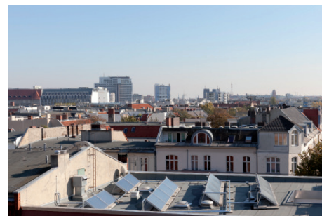
Solarthermische Anlage auf dem Dach der Feuerwache © Berliner NetzwerkE, Dietmar Gust
